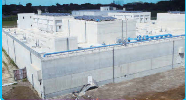
生物活性炭処理施設
