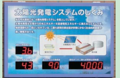
発電量等表示パネル
