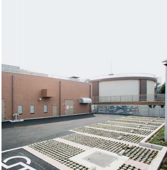
管理棟(左)・配水池(右)
