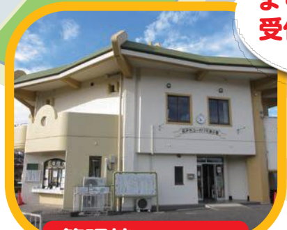
管理棟 (授乳室あり)
