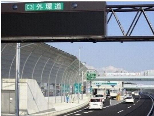
東京外かく環状道路松戸 IC 開通 (平成 30 年)
