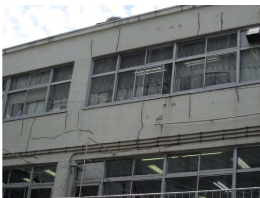
図6-2-4 本館外壁の状況
