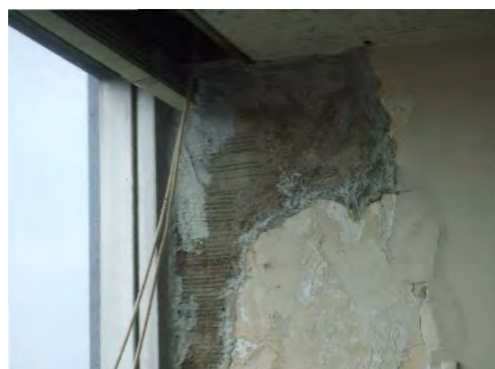
図6-2-5 内壁の損傷
