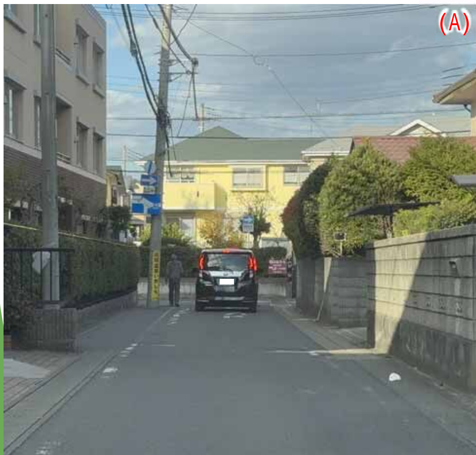
「じゃんけん道路（通称）」信号により追抜きが出来ず、通行に支障をきたす。
