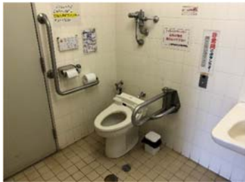
障がい者用トイレの整備状況
