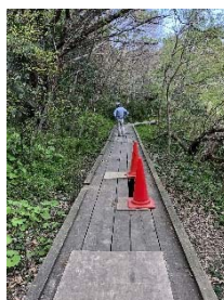
通路の老朽化状況
