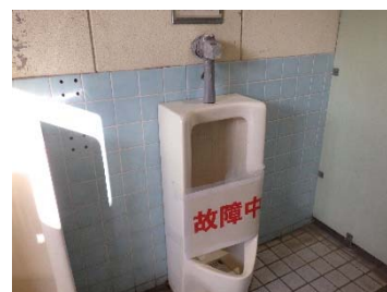
トイレの老朽化状況
