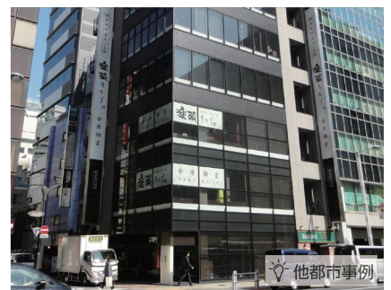
サインを設置する窓面を限定しつつ、建築物の外観と調和したデザインで掲出しています。
