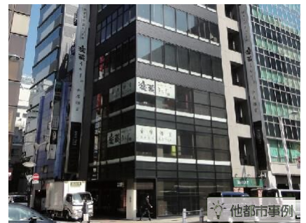
サインを設置する窓面を限定しつつ、建築物の外観と調和したデザインで掲出している例
