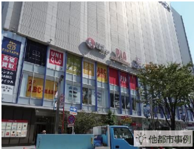
サイン類を3階以下の低層階に集約し、まちのにぎわいをつくり出している例
