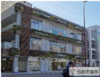
建物の外壁に壁面緑化を採り入れ、テナントのサインを箱文字で統一している例
