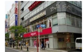
建物のデザインを活かした例（沿道建物）
