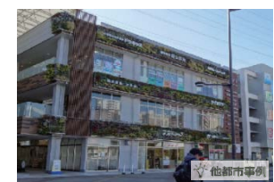
壁面緑化を取り入れサインを箱文字とした例（他都市）
