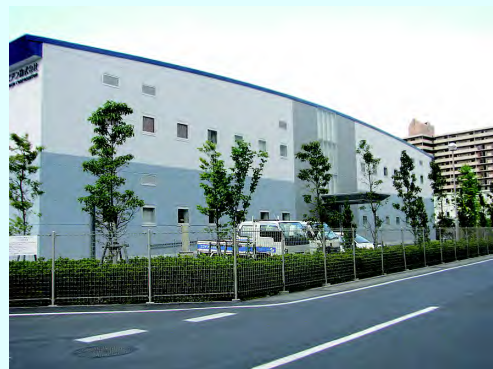
生垣と透過性のある柵による敷地境界
