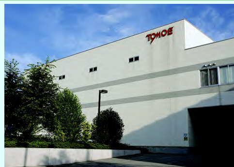
高明度・低彩度色が基本となっている工業施設
