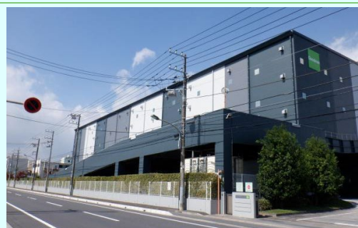
カラーグラデーションによる外壁の分節化と広告物のバランス（令和3年度松戸景観奨励賞受賞）
