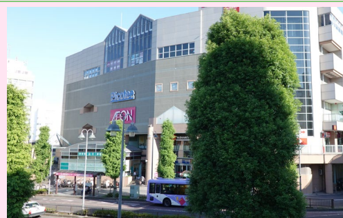
建材を組み合わせさせて色彩を分節化した商業ビル
