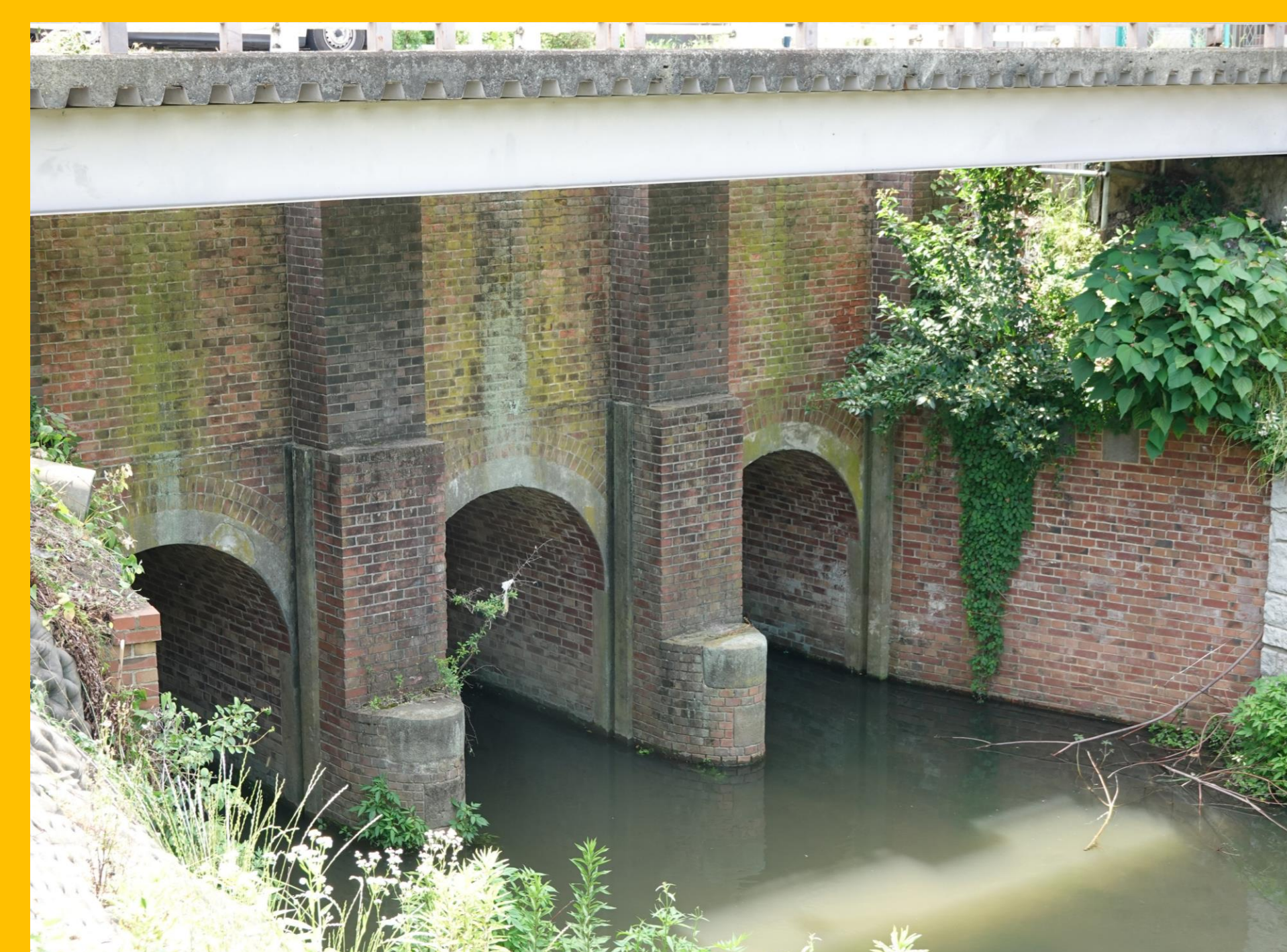
小山樋門（レンガ橋）
