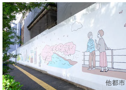
◎ 工事中仮囲い広告物におけるまち並みへの配慮
