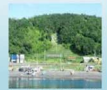
土砂崩壊防備保安林 (環境省HPより)
