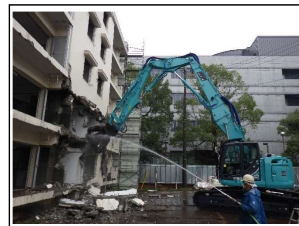
キ 解体作業時散水状況
