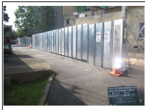
イ 仮囲い：万能鋼板H=2.0m
