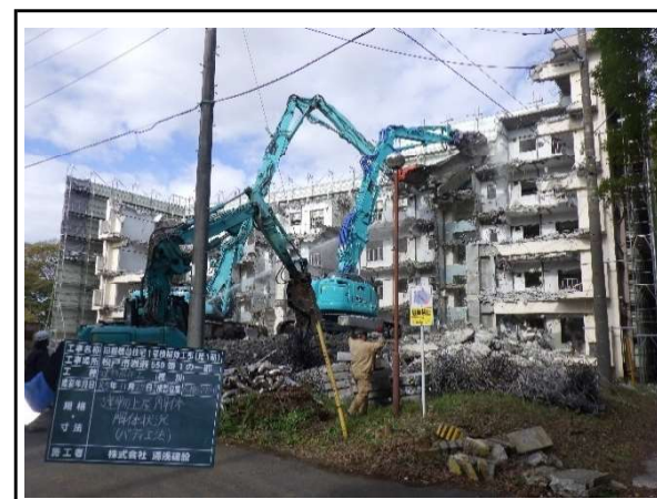
カ 建物解体施工状況
