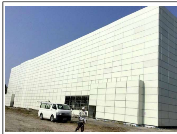
ア 外部足場（防音パネ張り）
