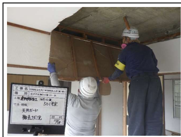
エ 内装解体施工状況
