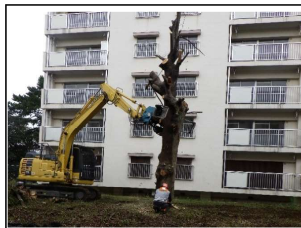
オ 樹木伐採施工状況
