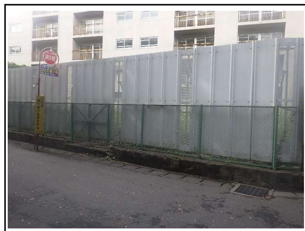
ウ 仮囲い：万能鋼板H=3.0m
