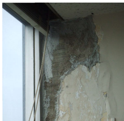
図 14 内壁の損傷
