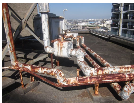
図 15 錆びついた給水管
