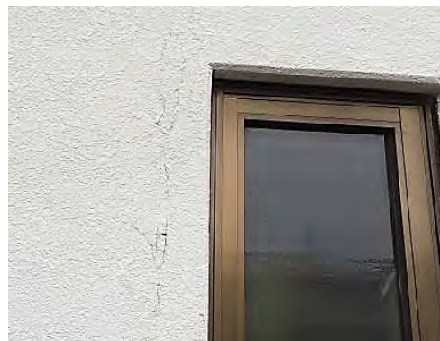
図 5-12 東部支所の劣化状況（左図：屋上、右図：外壁）
