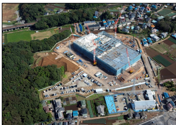
北西方向からの全景
