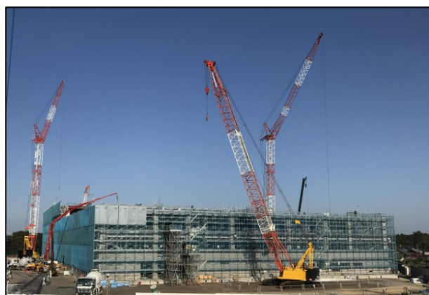
西方向からの現場の状況
