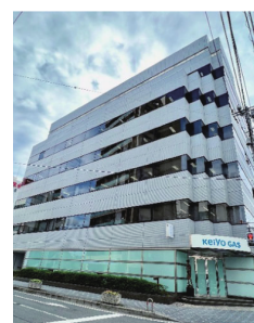
京葉ガスF松戸第2ビル4階
