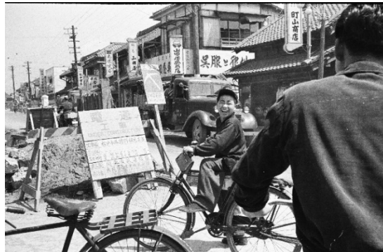
[写真4] 松戸駅近く、善照寺前の旧水戸街道 (小山・上本郷電話線工事／1955年)
