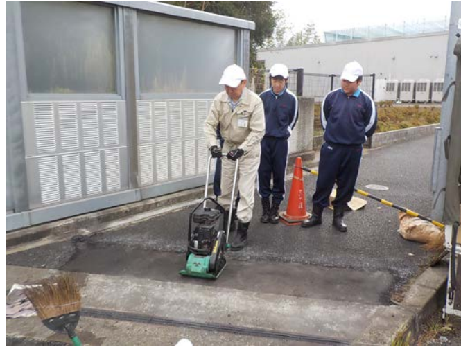
《職場体験で道路補修を行う様子》
