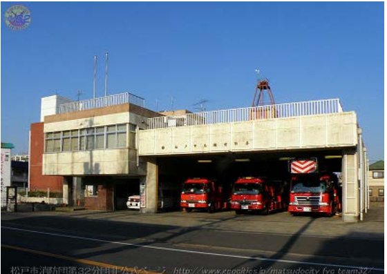
《5月に開署した馬橋消防署》
