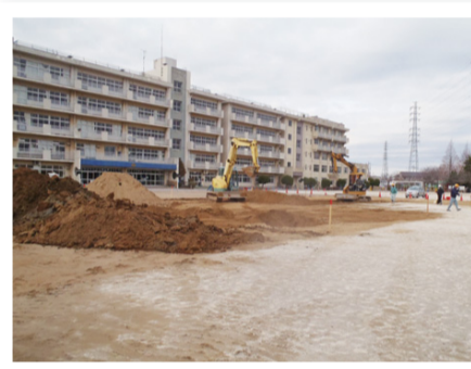
除染業者による小学校校庭の除染
