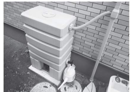
雨水貯留タンク
