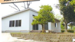
栗ヶ沢公園小金原八丁目会館
