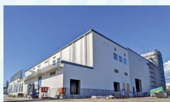
建設中の松戸市リサイクルセンター
