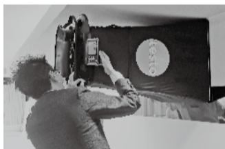
専用機材を使用して店内の風量を測定
