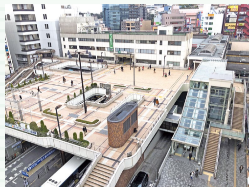
デッキ改修が進む松戸駅西口
