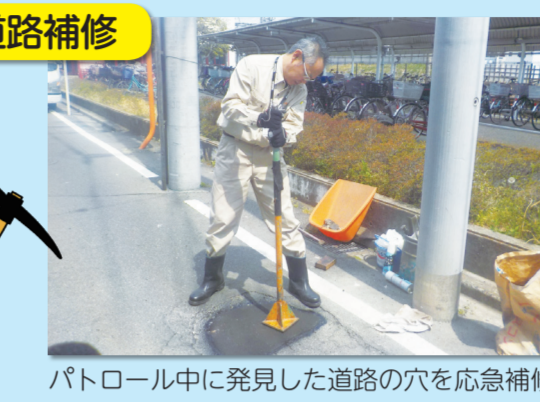
パトロール中に発見した道路の穴を応急補修しています。
