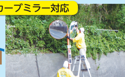
市民からの通報により、カーブミラーにかかった枝を危険と判断。枝を剪定し、ミラーの曇りを拭き取っています。
