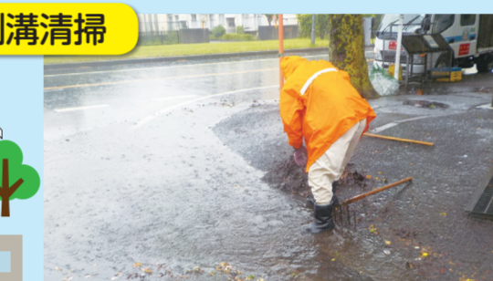
大雨の日に側溝の水があふれているとの通報を受けて現場に急行。ふたを取り外して、詰まった泥をかき出しています。
