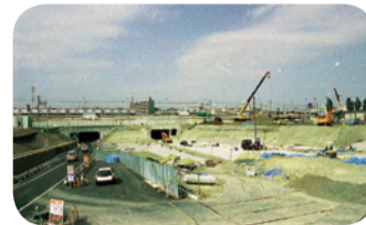
平成11年3月時点の東京外かく環状道路工事の様子
