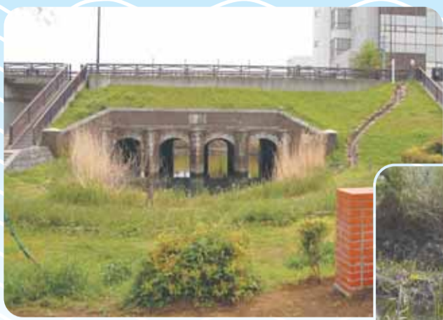
市の指定文化財「柳原水閘(やなぎはらすいこう)」。大雨の洪水対策として明治時代に造られました。
