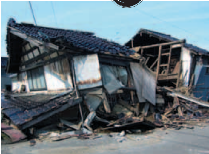
平成19年7月16日に発生した新潟県中越沖地震によって倒壊した家屋
