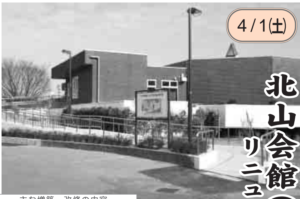
第一式場(小式場)入口へ続くスロープ
