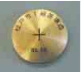
基準点であることを示す金属製のしるし
