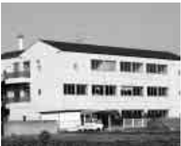
(仮称)シニア交流センター建設予定地(旧ハローワーク松戸馬橋庁舎)
