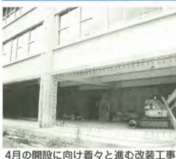
4月の開設に向け着々と進む改装工事
