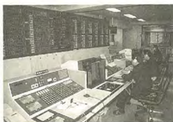
消防局中央指令室
