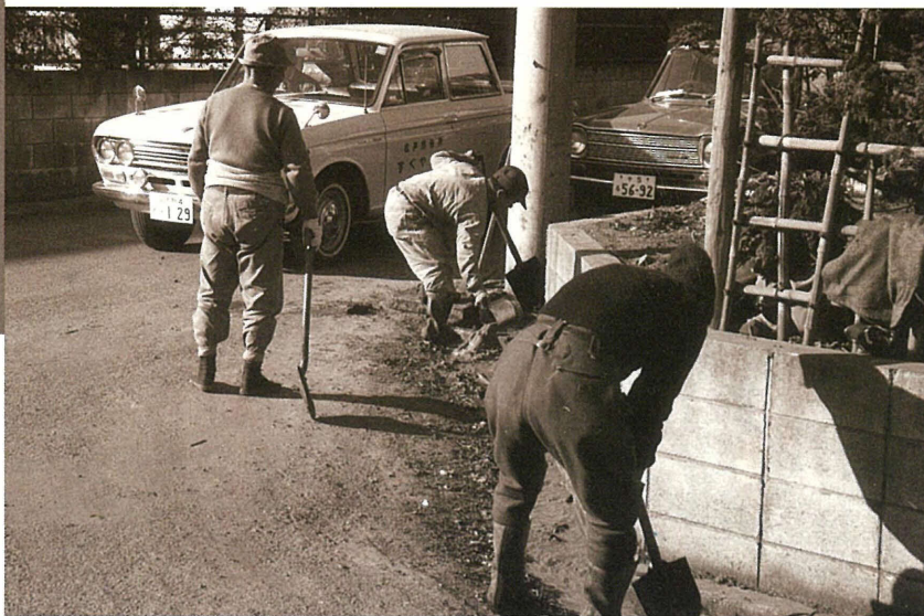
昭和44年・道路側溝の補修をする すぐやる課の職員
