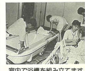
室内で浴槽を組み立てます
