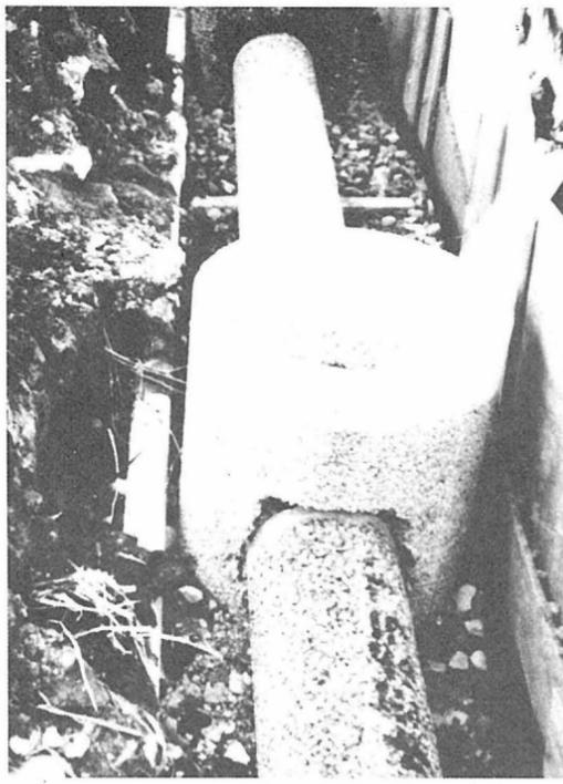
雨水を地下に浸透させるますと地下埋管
