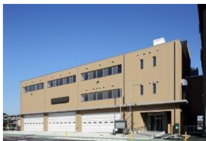
▲ちば北西部消防指令センターが入る 松戸市中央消防署
