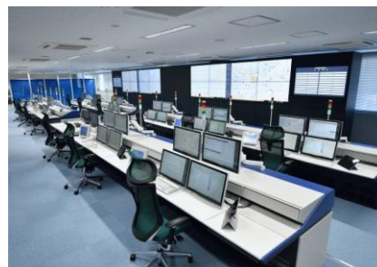
▲ちば北西部消防指令センター
