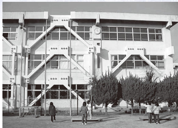
耐震改修済の学校
