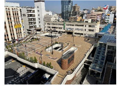
■松戸駅西口デッキの整備
