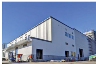
■松戸市リサイクルセンター
