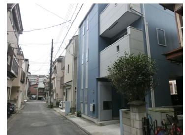
■密集市街地で形態制限の緩和により老朽建物の建替えを進めている事例（江戸川区）
