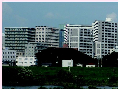
壁面やスカイラインのまとまり
