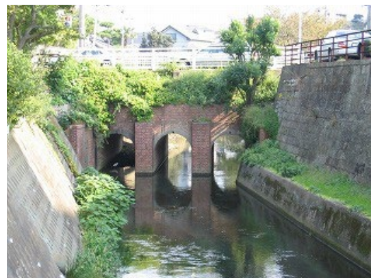
小山樋門（レンガ橋）
