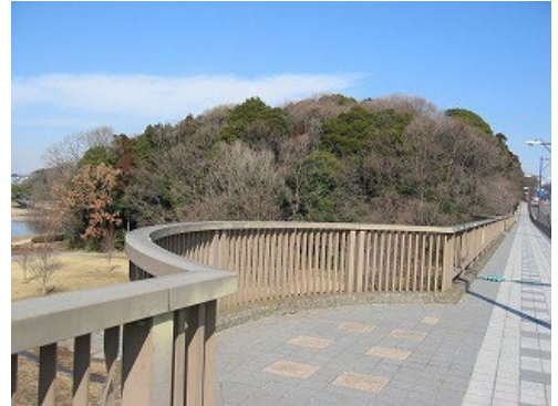
豊かなみどりが眺望できる「広場の橋」のテラス
