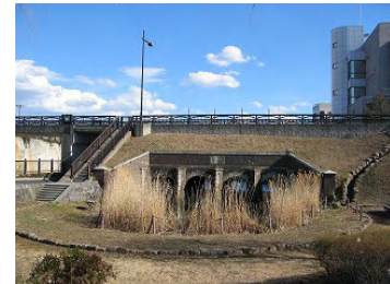
柳原水閘(土木学会選奨土木遺産)
