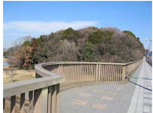
豊かな緑が眺望できる「広場の橋」のテラス
