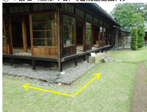
⑧雨落ち溝〔表座敷棟南・西側〕
