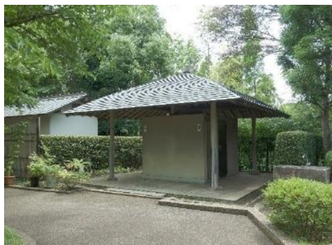
③②屋外トイレ
