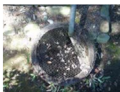
㉒-1 雨水排水設備（溜め壺型）〔使用者の間東側〕
