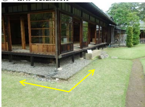
⑧雨落ち溝〔表座敷棟南・西側〕
