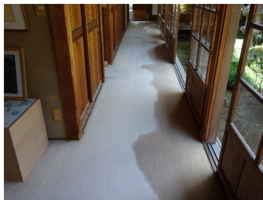
渡り廊下棟（西を見る）
