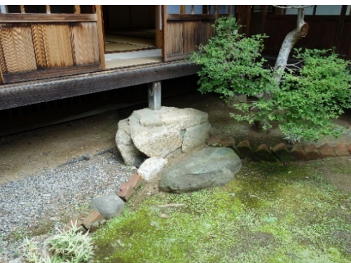
⑪-7 沓脱石〔奥座敷棟南側〕
