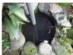
㉒-5 雨水排水設備（溜め壺型）〔表座敷棟北側〕
