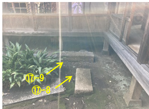
⑪-8、⑪-9 沓脱石〔奥座敷棟東側〕
