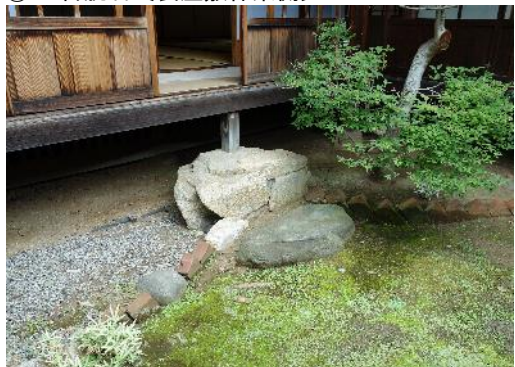
⑪-7 沓脱石〔奥座敷棟南側〕
