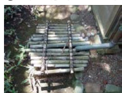
㉒-1 雨水排水設備（溜め壺型）〔使用者の間東側〕
