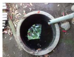
㉒-6 雨水排水設備（溜め壺型）〔離座敷棟南側〕
