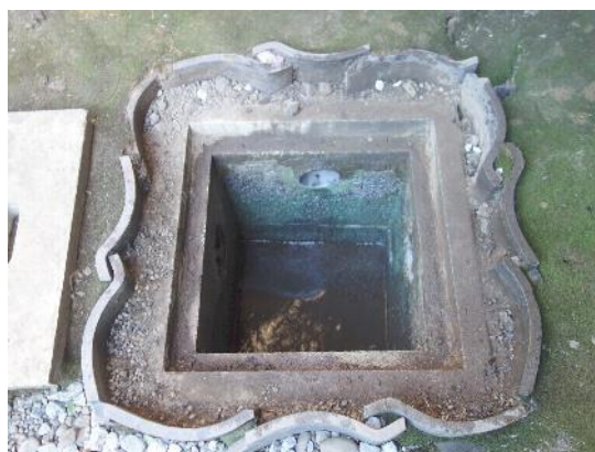
降雨時の中庭（玄関棟）の排水状況（右上が雨水浸透枳） 雨水浸透枳の内部
