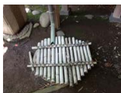
㉒-6 雨水排水設備（溜め壺型）〔離座敷棟南側〕
