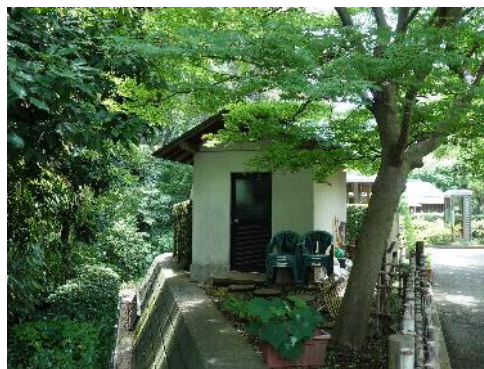
③③放水銃用のポンプ小屋（今後は易操作性消火栓用として使用予定）
