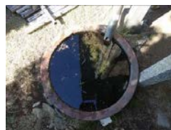
㉒-4 雨水排水設備（溜め壺型）〔表座敷棟南側〕
