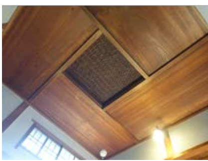
杉板網代組の天井
