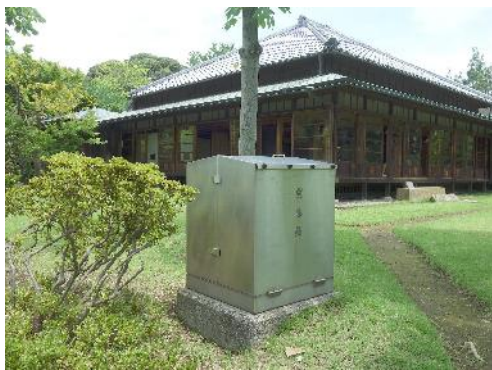
㊹-4 放水銃(令和7～8年度の工事により撤去予定)
