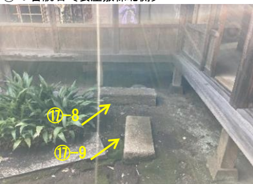
⑪-8、⑪-9 沓脱石〔奥座敷棟東側〕
