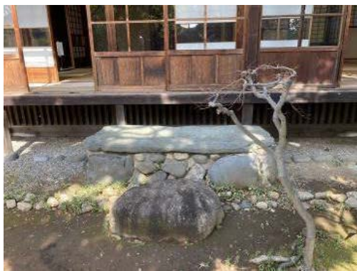
⑪-3 沓脱石〔離座敷棟南側〕
