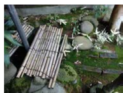
㉒-5 雨水排水設備（溜め壺型）〔表座敷棟北側〕
