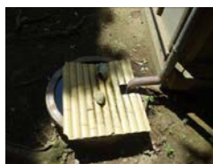
㉒-8 雨水排水設備（溜め壺型）〔離座敷棟東側〕
