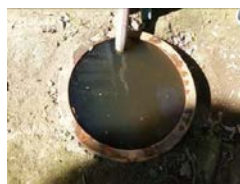
㉒-8 雨水排水設備（溜め壺型）〔離座敷棟東側〕
