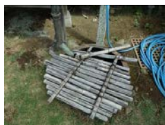
㉒-4 雨水排水設備（溜め壺型）〔表座敷棟南側〕
