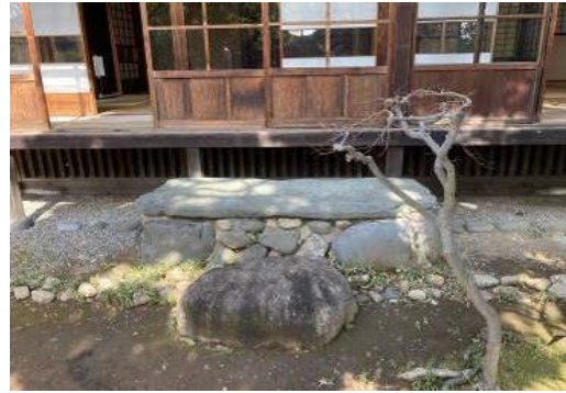
⑪-3 沓脱石〔離座敷棟南側〕
