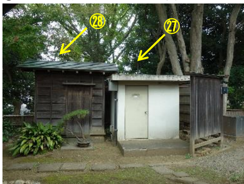
㉗屋外消火栓用のポンプ小屋（今後は使用しない） ㉘水圧小屋（現在使用していない）
