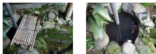
⑫-5 雨水排水設備（溜め壺型）〔表座敷棟北側〕
