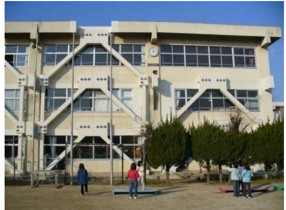
耐震改修済の学校
