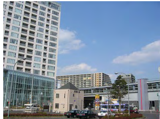
市街化が進む東松戸駅前
